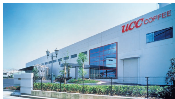
隣接するレギュラーコーヒー工場とパイプラインで結び、原料のレギュラーコーヒーから製品の缶コーヒーまでの一貫生産体制を確立した「UCC兵庫飲料工場」
